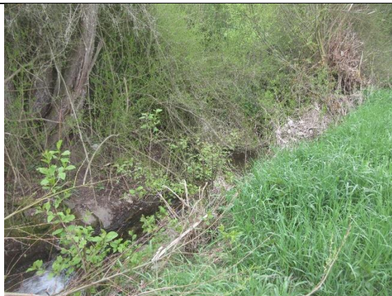
Verbau Mündungsbereich Pfingstbrunnengraben
