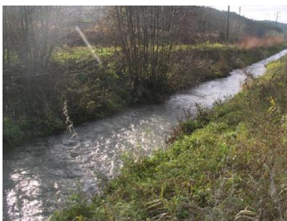
Begradigter Abschnitt des Wittigbachs Foto: Ingenieurbüro Prof. Dr. Klärle 2010
