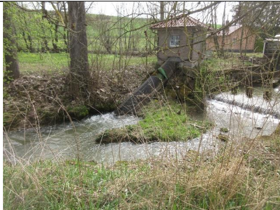
Wehr mit Sohlschwelle
