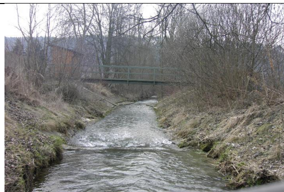
Sohlschwelle in Grünsfeld
